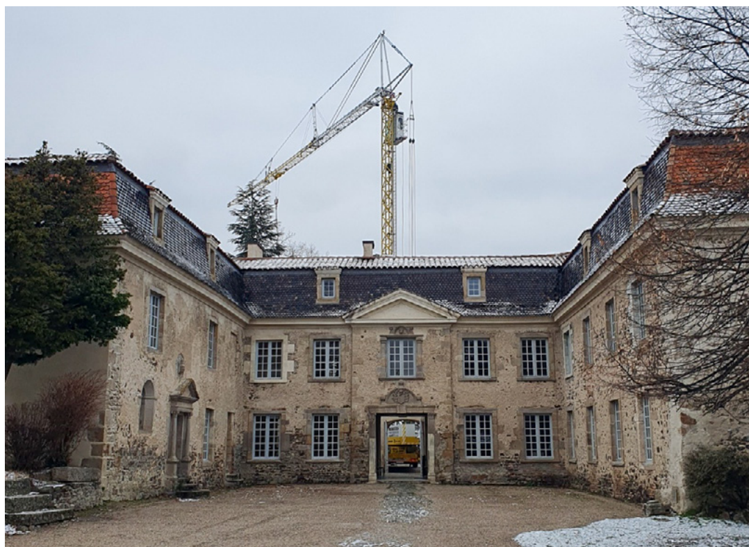
Travaux de soutènement - © Château de Goutelas
