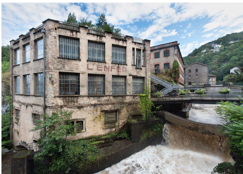
L'Usine du Creux de l'Enfer, fermée temporairement pour travaux. © Vincent Blesbois
